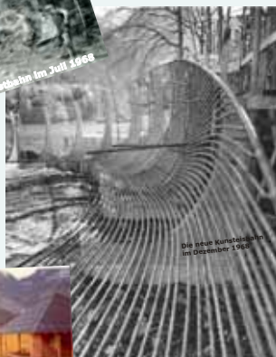
Kurve 16 (Echowand) bei der Herstellung der Berohung
